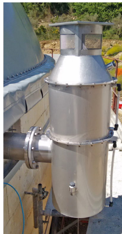
SOUPAPE DE SÉCURITÉ POUR SURPRESSION-DÉPRESSION
