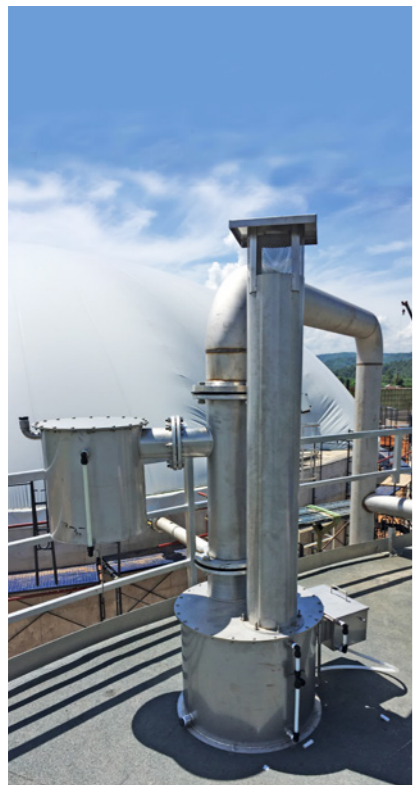
SOUPAPE DE SÉCURITÉ HYDRAULIQUE AVEC SYSTÈME ANTI-DÉPRESSION
