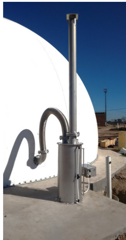
SOUPAPE DE SÉCURITÉ HYDRAULIQUE
